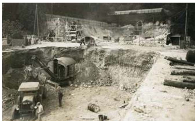
Construction du tube nord du tunnel
