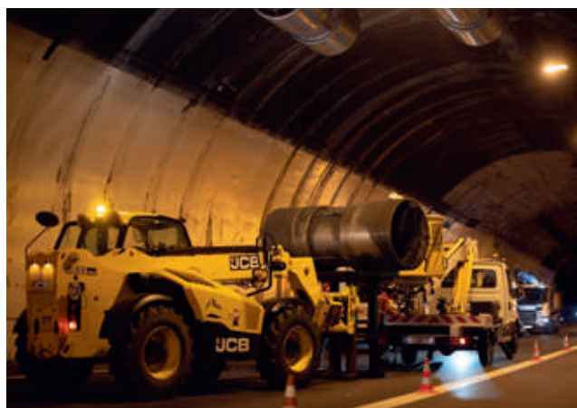
Inspection réglementaire du tunnel de 2024
